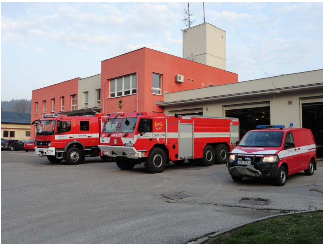
Požární stanice v Trutnově, Náchodská 475
