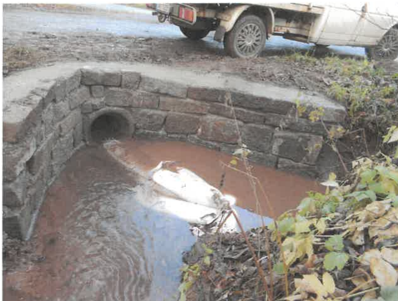
Opravený propustek po povodních – Bojiště
