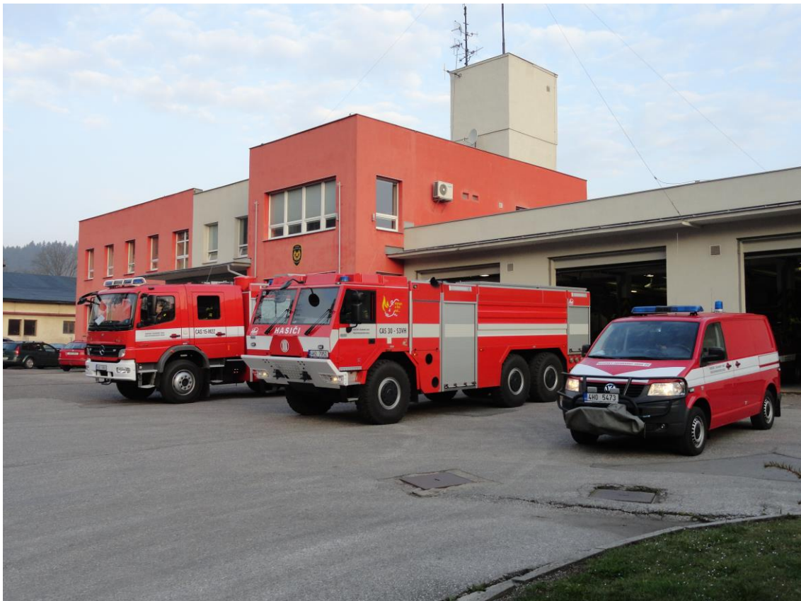
Požární stanice v Trutnově, Náchodská 475
